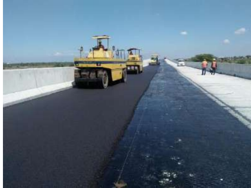
Gambar 2.2 Perkerasan Jalan Lentur
