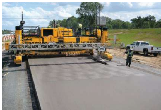
Gambar 2.3 Perkerasan Jalan Kaku
